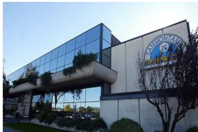
Figura 1 Stabilimento principale Sammontana a Empoli (FI)
